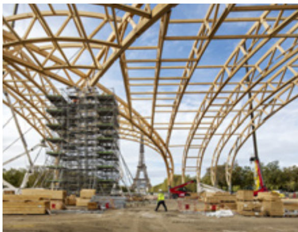
Chantier du Grand Palais éphémère.
